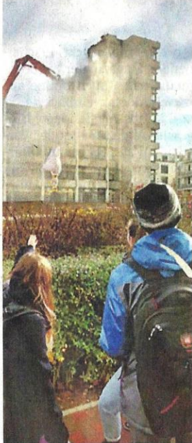
Schon beim Abriss vor Ort: Schüler der LFS.
